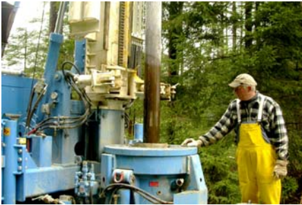
Probebohrungen im Höhenkirchener Forst zur Erschließung des neuen Wasserfördergebietes
