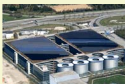
Aufdachanlage Messe München
